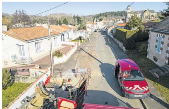
Les travaux devraient durer jusqu'au 15 avril.
